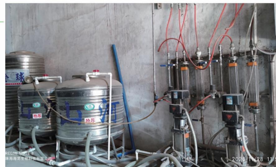
15T锅炉炉内脱硝装置
