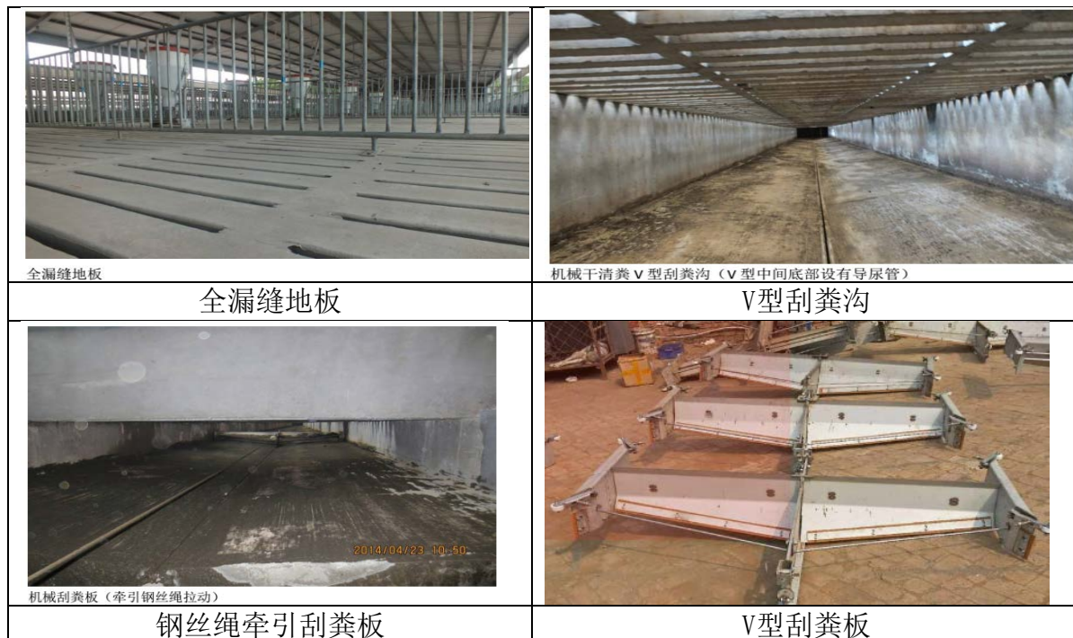
图 2-4 猪舍设计模式与清粪方式示意图
